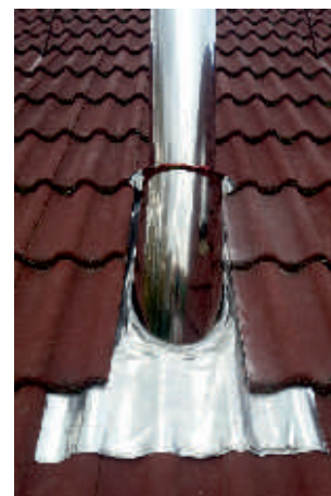
střešní olověné oplechování
